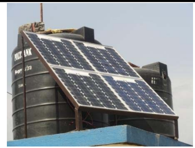
後日屋上に設置されたパネル
